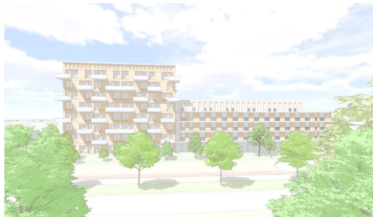
Overkant, 3e verdieping
